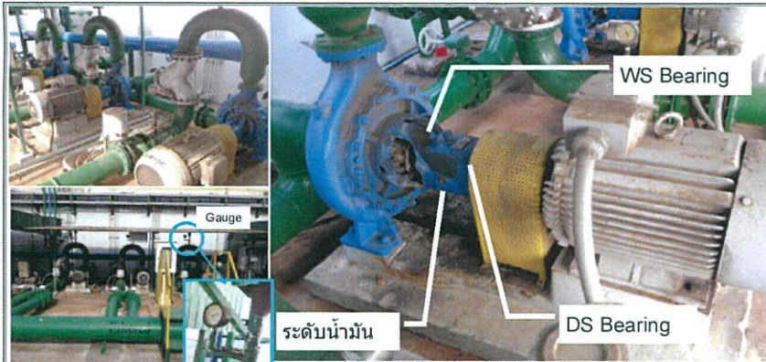
รายละเอียดของ Pump Brand : Ebara Model : 150x100 IFWM Serial no. : RU11596-06 Type : Horizontal Single Suction Pump
