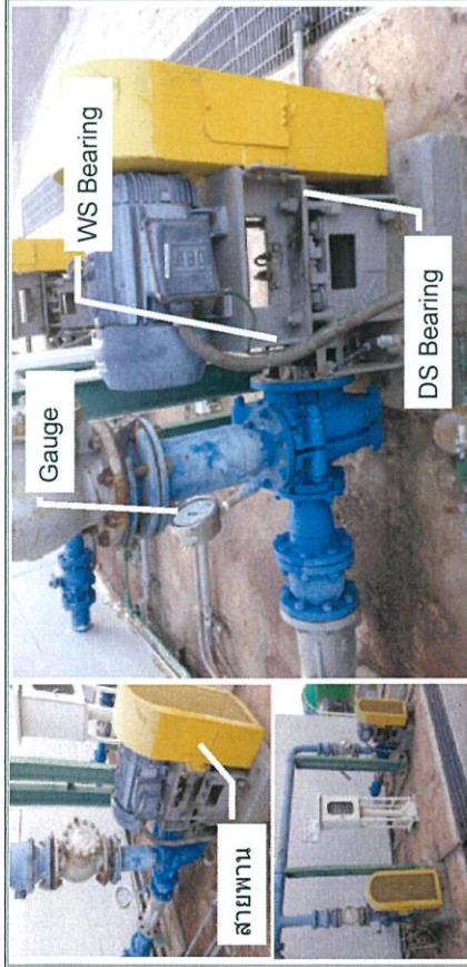
รายละเอียดของ Pump Brand : Funikawa Model : SPN-80FC Type : Sludge Pump rpm : 1370
