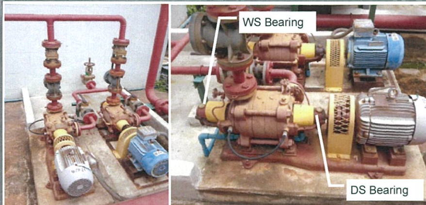
รายละเอียดของ Pump Brand : Ebara Model : 40MS2103M Serail no. : RU11596-13 Type : Multi-stage Pump (Jockey Pump)
